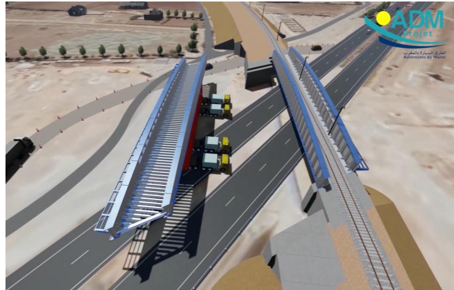
Simulation de pose des ponts métalliques
