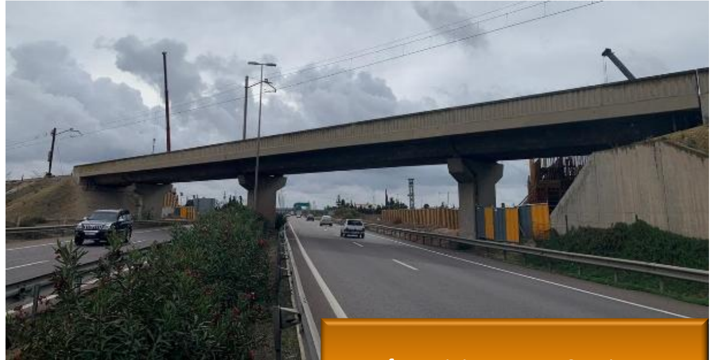
Pont ferroviaire au PK 12 qui entrave le triplement de l'autoroute
